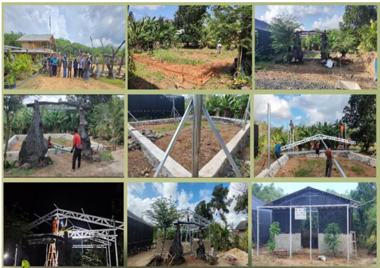
Gambar 3 Proses pembangunan greenhouse anggrek di Desa Sabuhur
